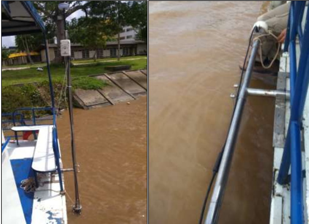
Figura 19 - ADCP instalado na embarcação.
